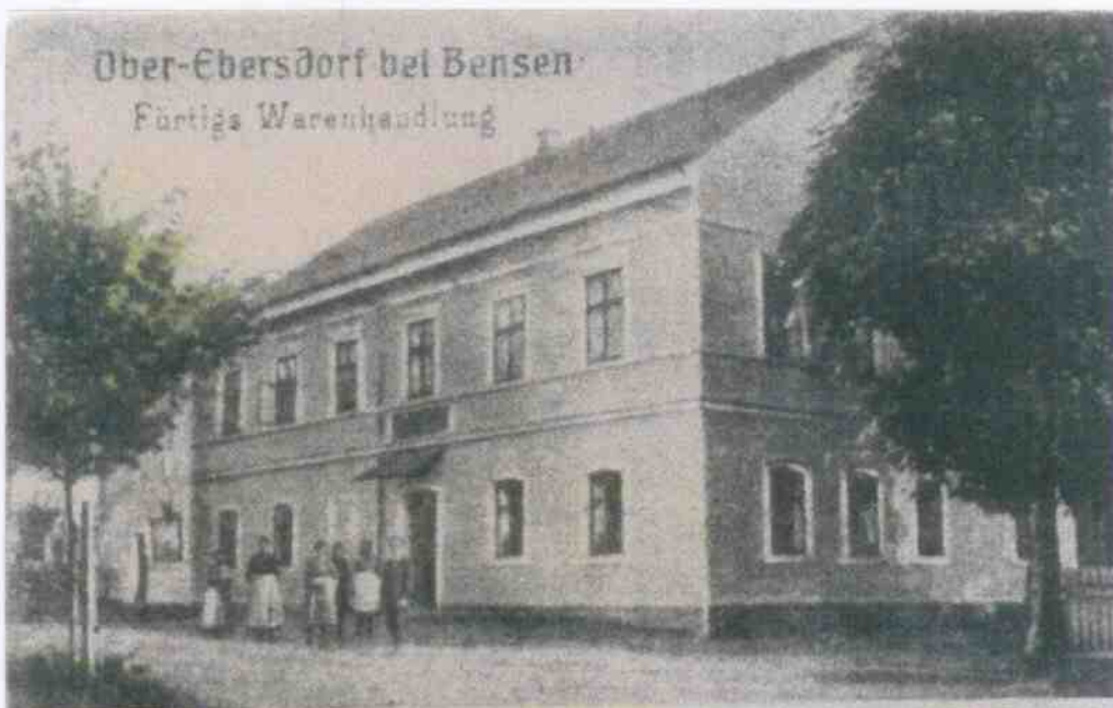
Dolní obchod č.p. 109 Franze Fürtiga. Ten zde od roku 1884
